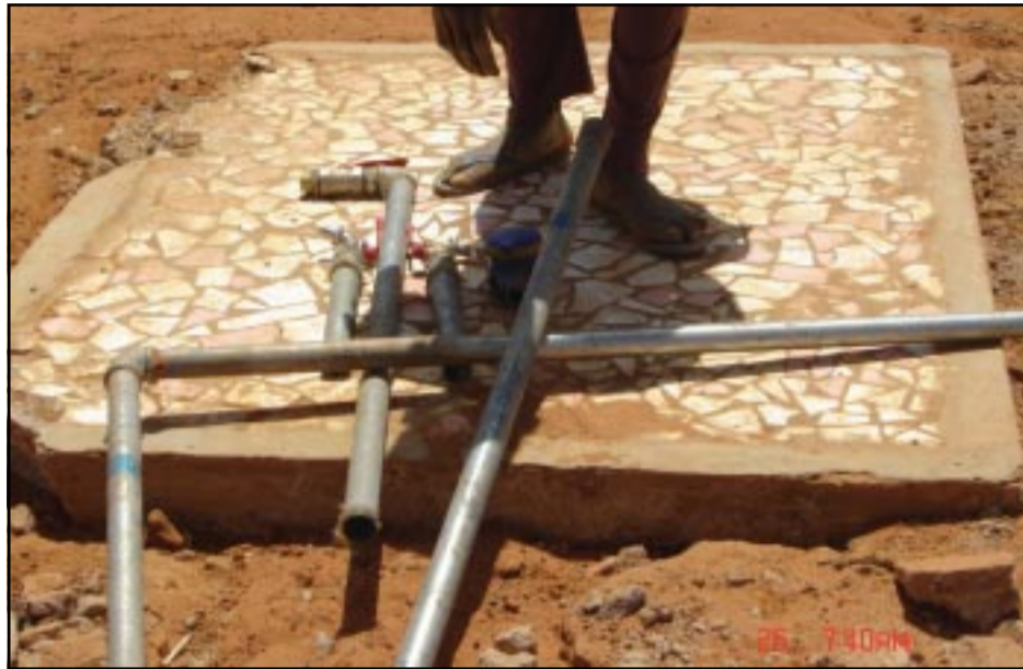
Les installations démontées
